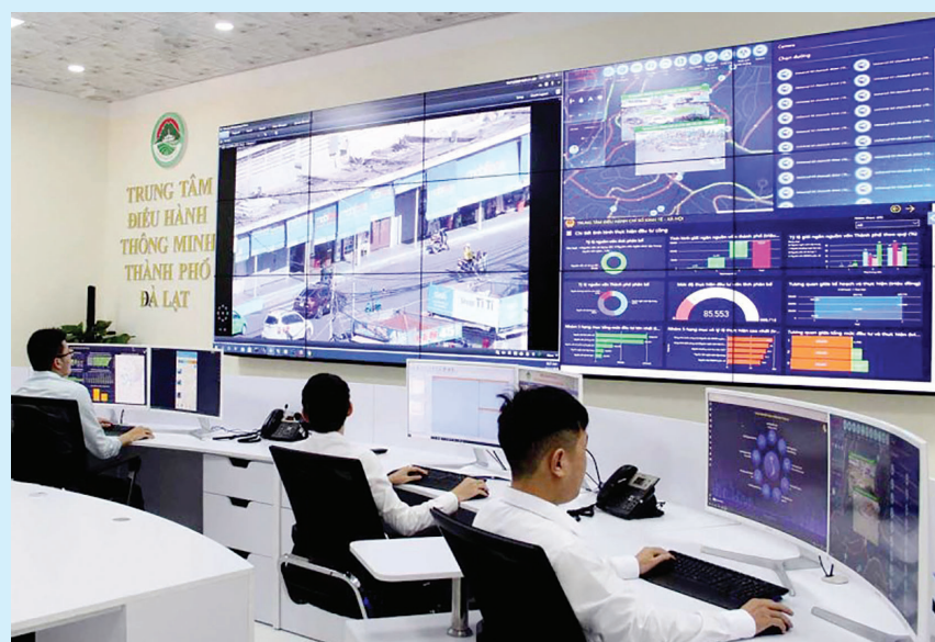
Trung tâm điều hành thông minh thành phố Đà Lạt.
