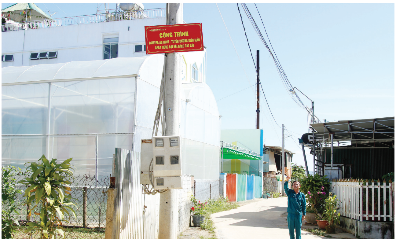
Công trình camera an ninh và tuyến đường kiểu mẫu của thôn.
